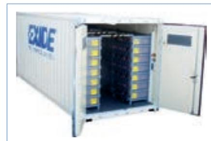
Модуль построен на базе аккумуляторов Sonnenschein Solar A600, герметизированных с электролитом в желеобразном состоянии.
