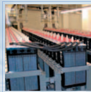
Рис. 17 Смонтированная батарея Classic OCSM
