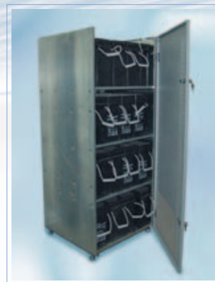
Рис. 10 Смонтированная батарея Tudor FT
