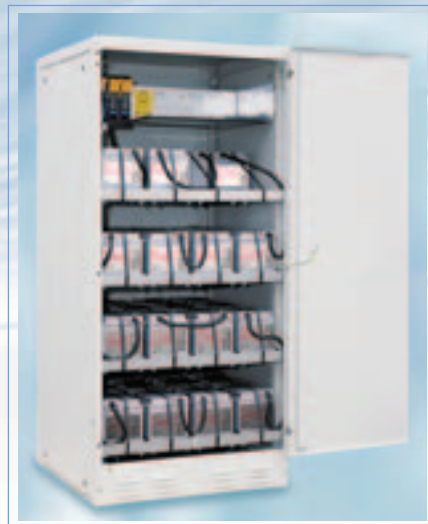
Рис. 11 Смонтированная батарея Sprinter P
